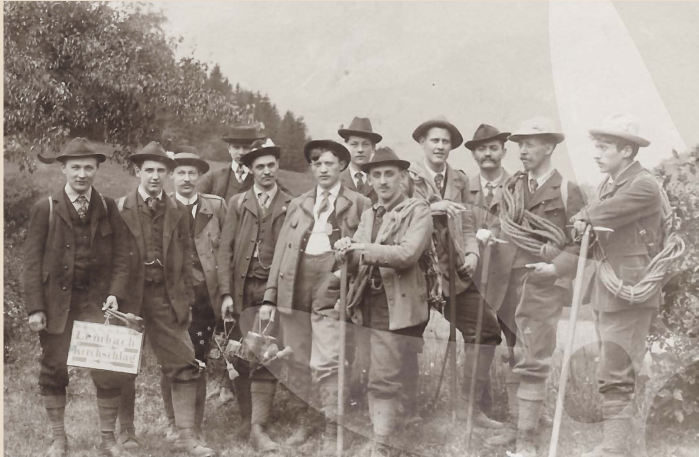
Mitglieder einer Sektion bei Wege- und Markierungsarbeiten, um 1900
